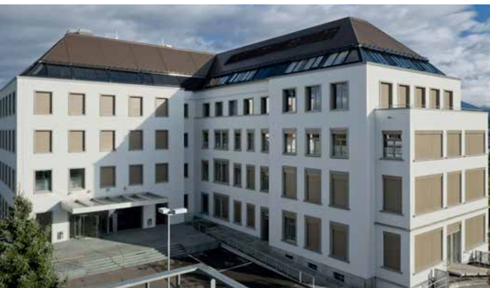
■ Die Dachkonstruktion ist eine Stahlskelettkonstruktion, die Ausfachung der Dachflächen erfolgte im Montagbau Holz mit kerngedämmten Holzelementen. Die Dachflächen wurden mit Blech eingedeckt. (Bilder: zVg)
